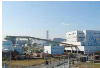
中防不燃ごみ処理センター
