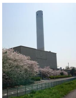
多摩川清掃工場
